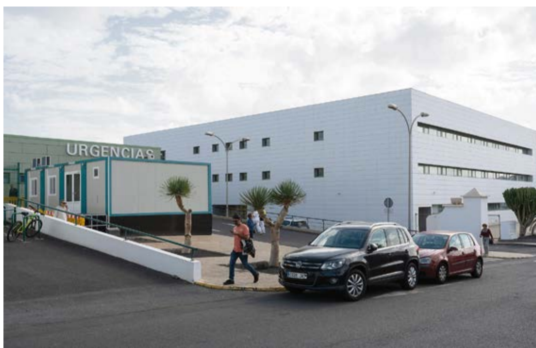
Edificio polivalente anexo al Hospital General, aún sin recepcionar.
