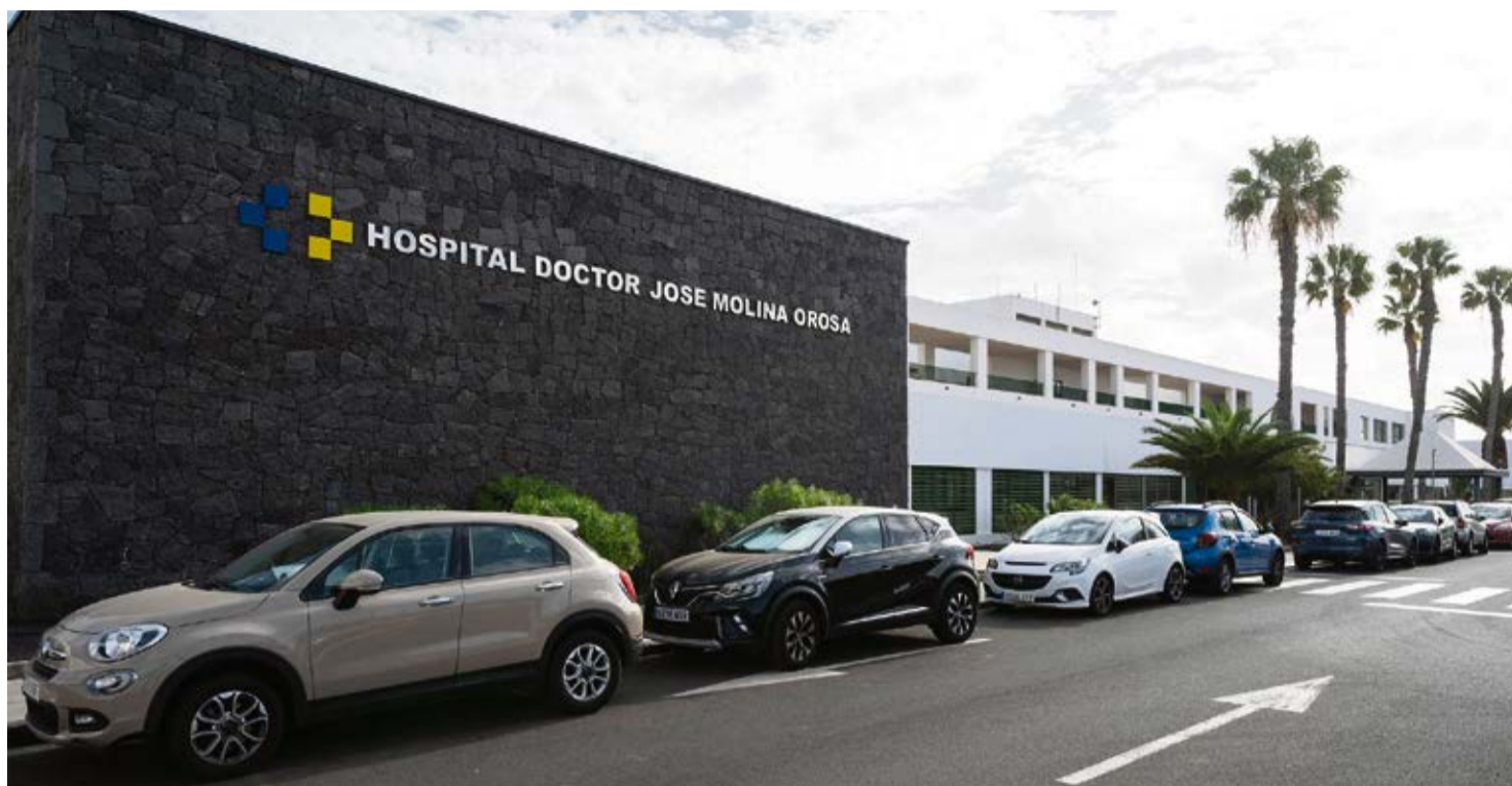
El Plan Director fijará las futuras actuaciones en el Hospital Molina Orosa.
