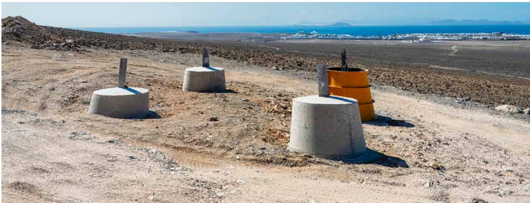
Bases de una de las nuevas torretas eléctricas en la falda de Los Ajaches. Foto: Adriel Perdomo.
