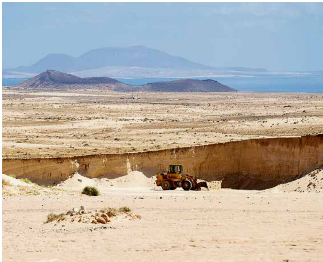
Una pala mecánica extrae arena.
