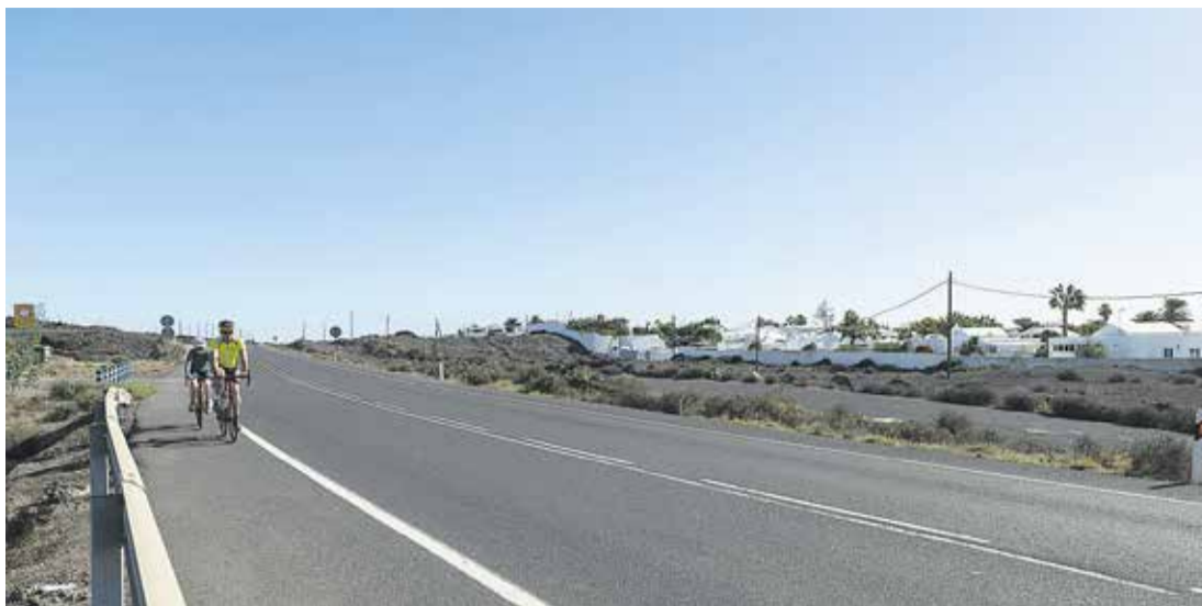
Actual carretera LZ-40 y el nuevo trazado de la futura autovía de Puerto del Carmen, en el entorno de la rotonda de El Toro.
