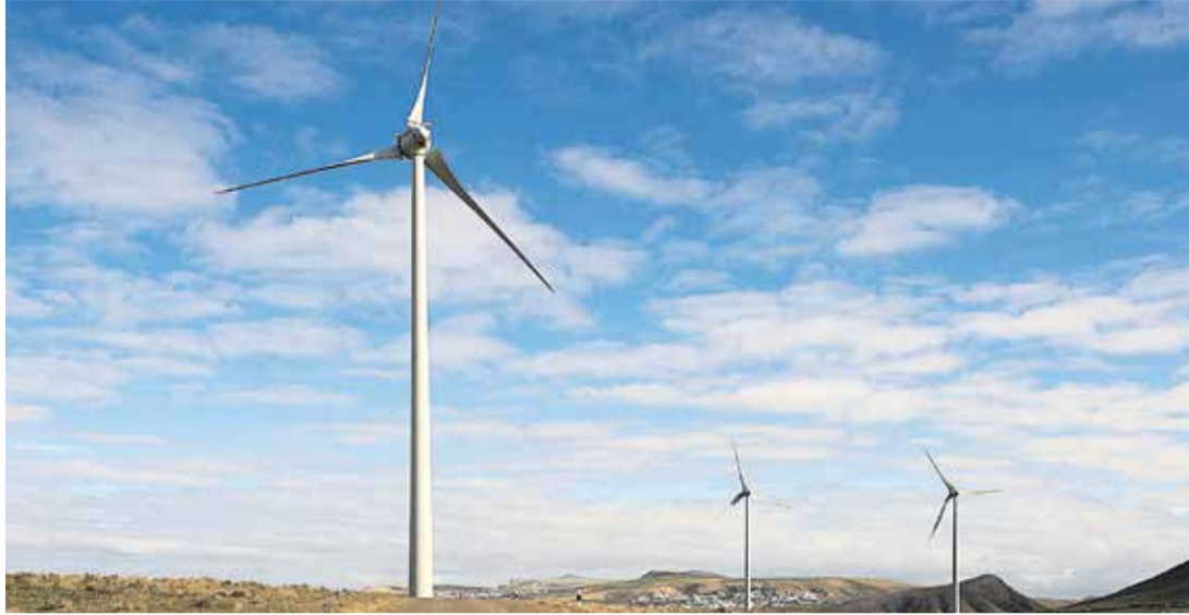
Aerogeneradores instalados en Lanzarote. Foto: Adriél Perdomo.
