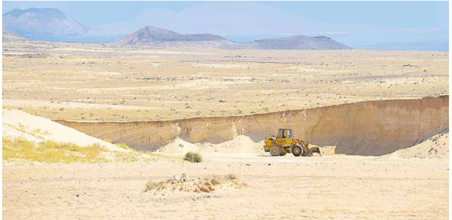
Zona de extracción de jable. Foto: Adriel Perdomo.
