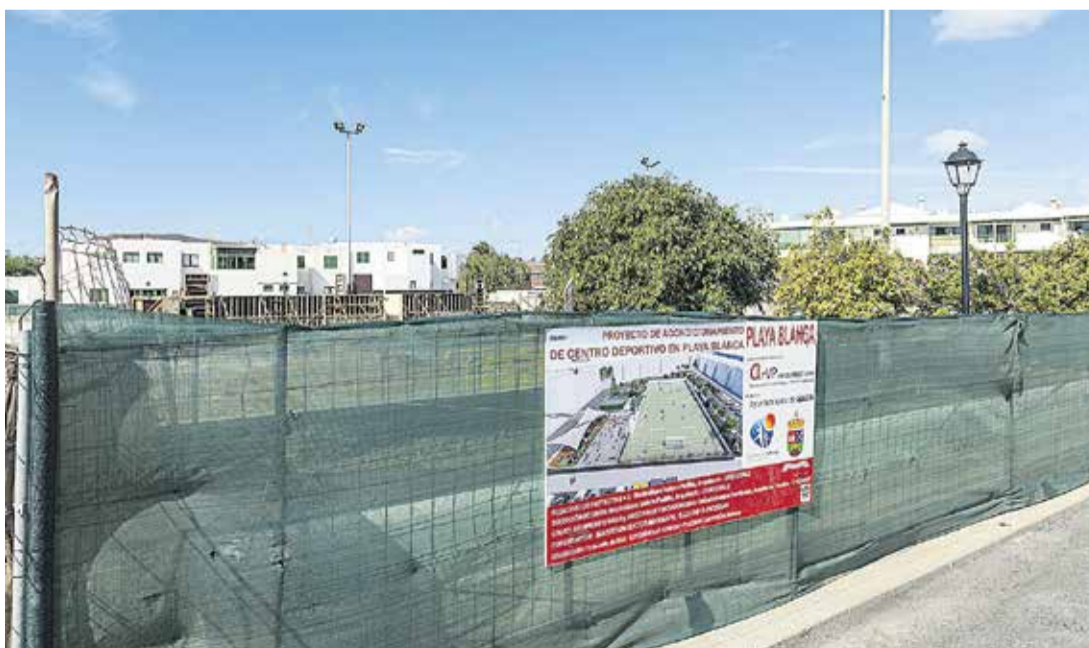
Obras de remodelación de la cancha del centro de Playa Blanca.
