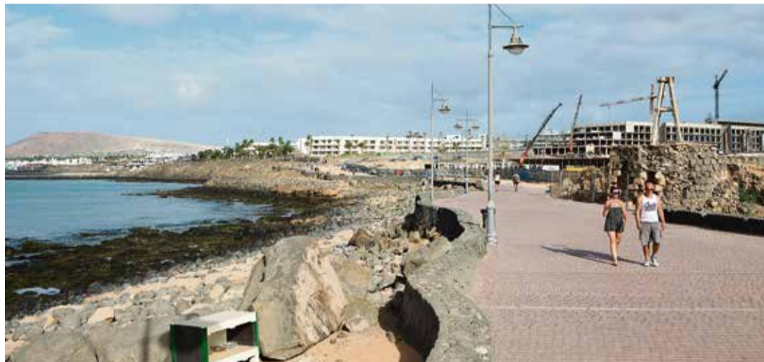
Al fondo, obras del nuevo macrohotel en Playa Blanca. Foto: Adriel Perdomo/Archivo.
