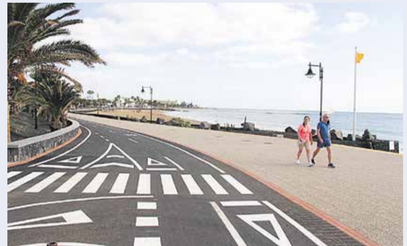
Reparación de la Avenida de Las Playas.
