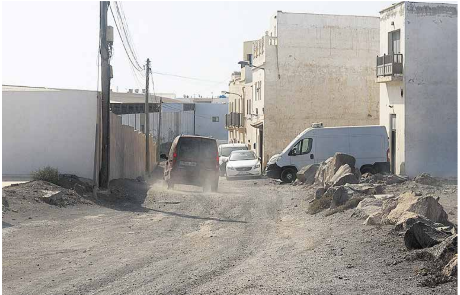
El problema principal es que la calle no está asfaltada. Foto: Adriel Perdomo.
