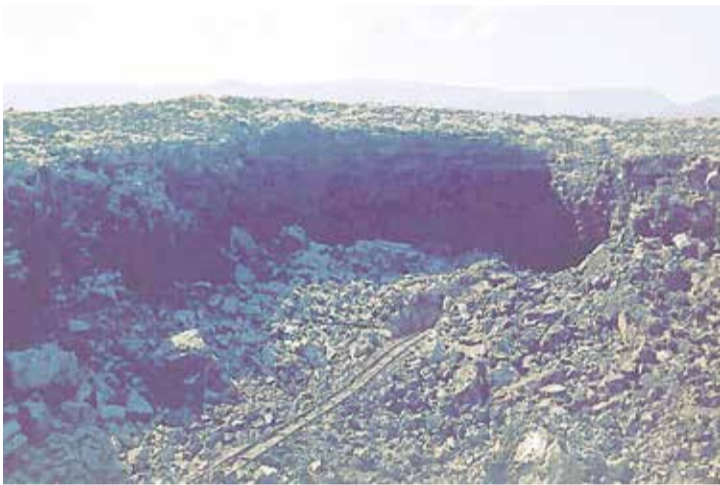
Fotografía del denominado 'Jameo grande', de Los Jameos del Agua, durante el dragado del lago. Se distinguen muy visiblemente los raíles de la vagoneta que se montó para el traslado de materiales al interior de la misma, durante el periodo de restauración. Imagen de 1965 cedida por Félix Sanz Illescas a Memoria Digital de Lanzarote.
