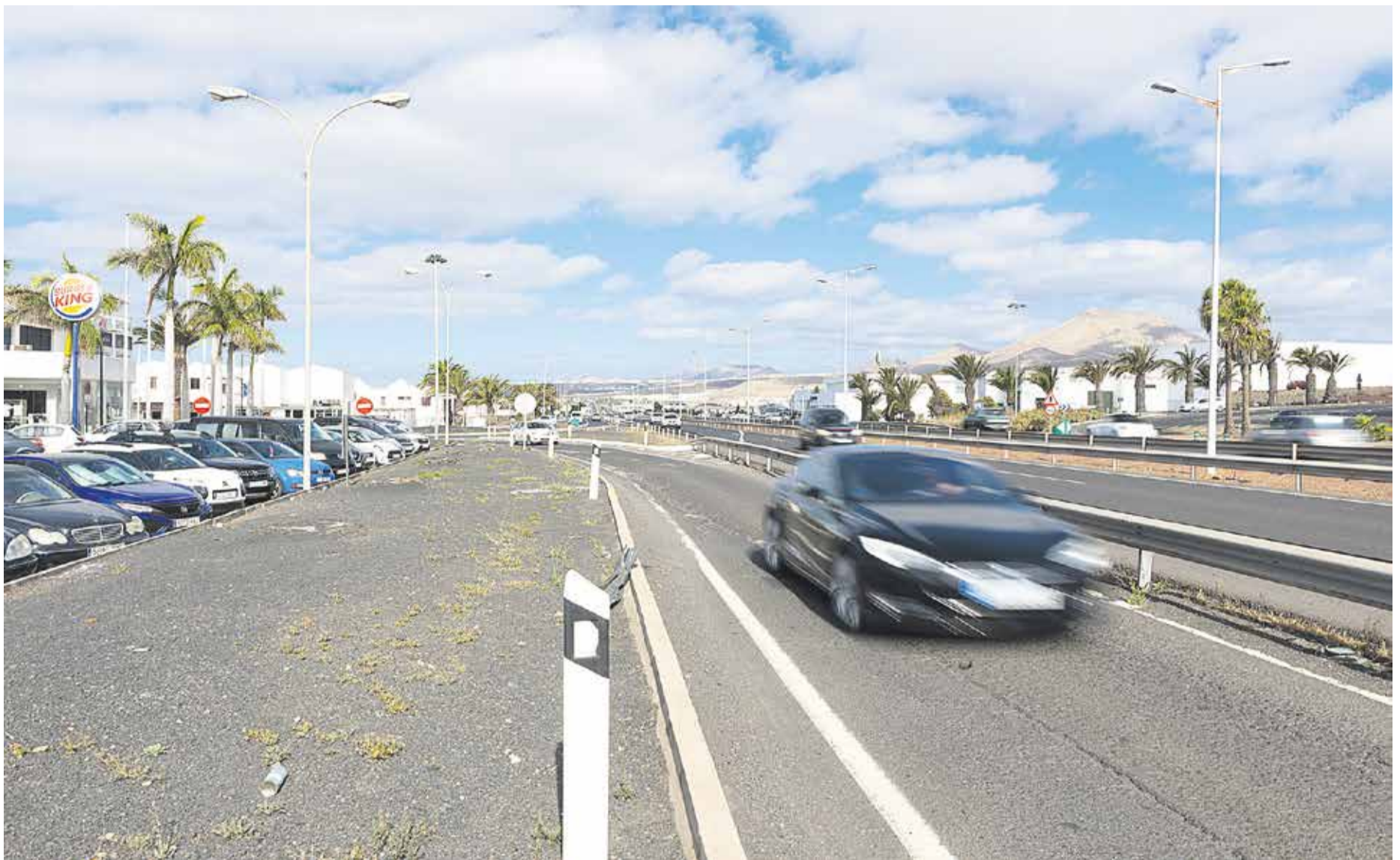
Actual vía de acceso a Playa Honda. Foto: Adriel Perdomo.
