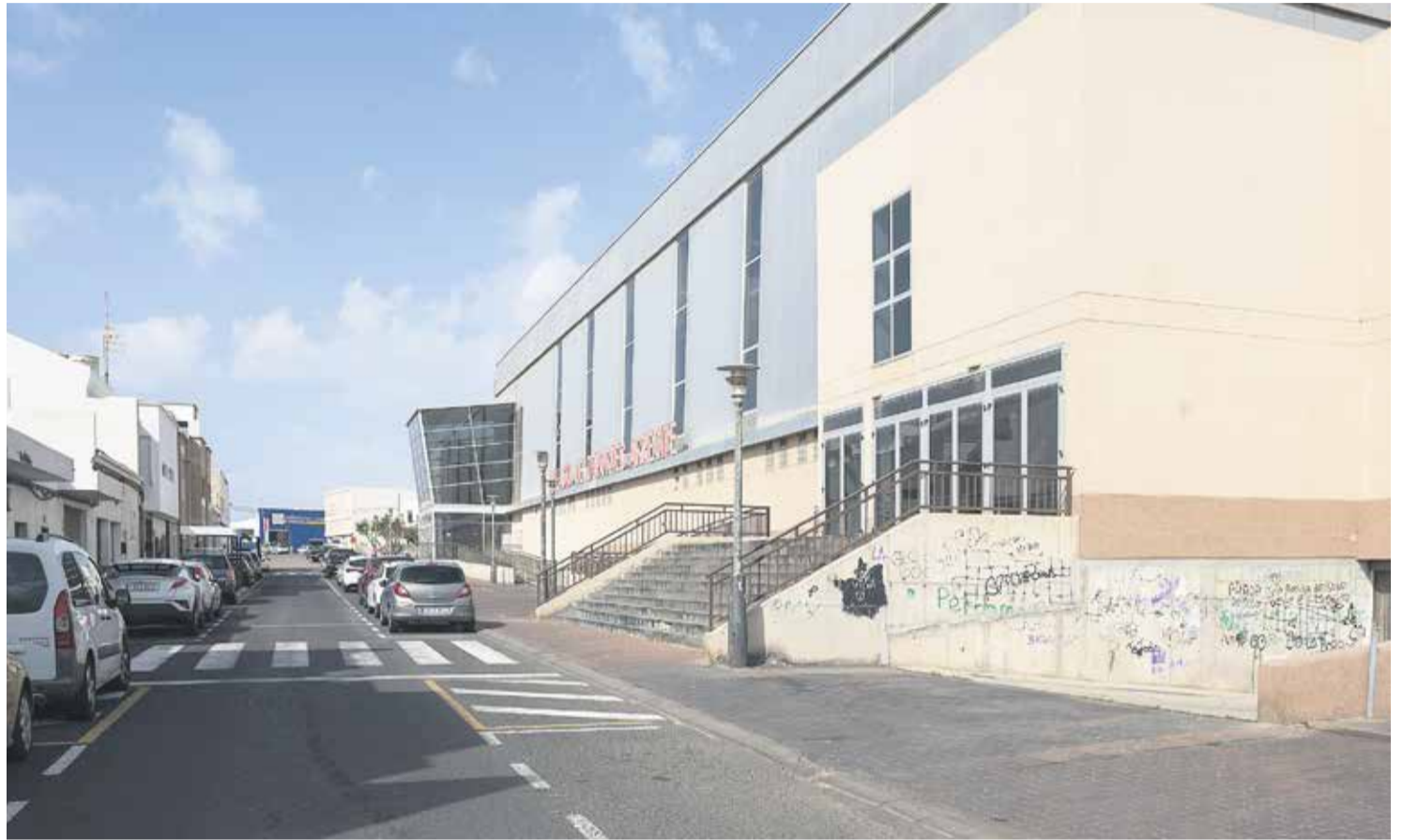
Pabellón de deportes de Argana Alta. Fotos: Adriel Perdomo.
