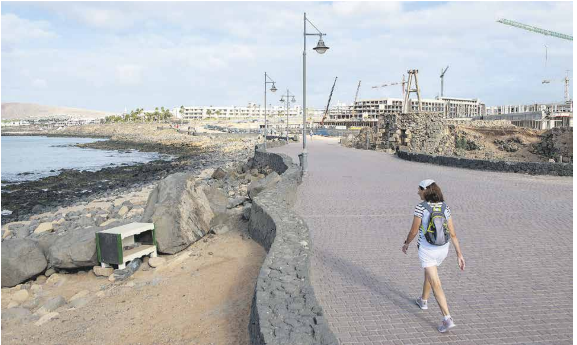
Paseo marítimo de Playa Blanca, con el autoproclamado hotel más grande de la Isla, en construcción. Foto: Adriel Perdomo.
