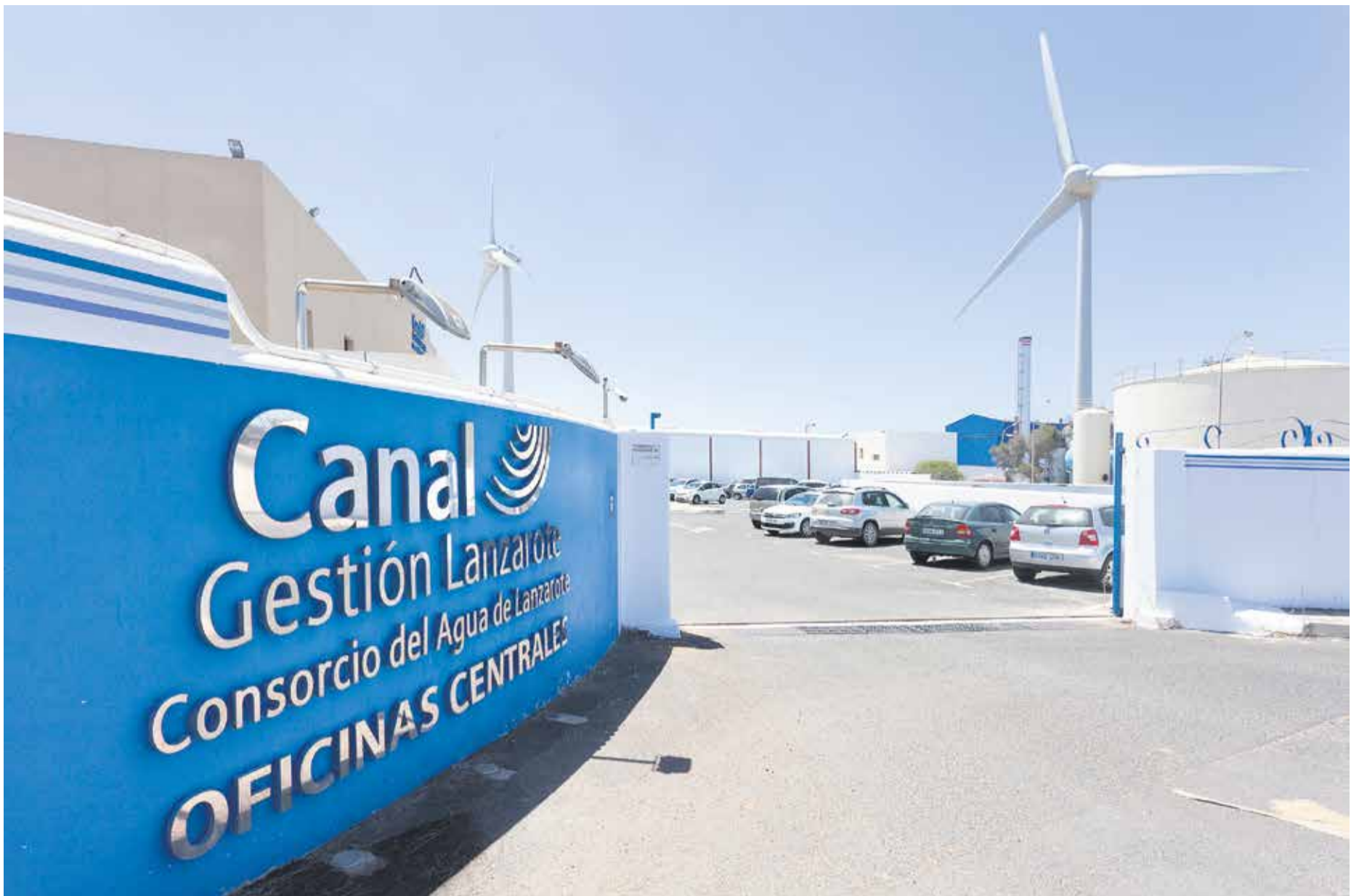
Central de desalación de Punta de los Vientos. Foto: Diario de Lanzarote.
