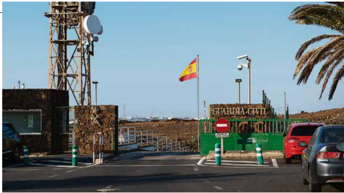
Cuartel de la Guardia Civil en Costa Tegui.
