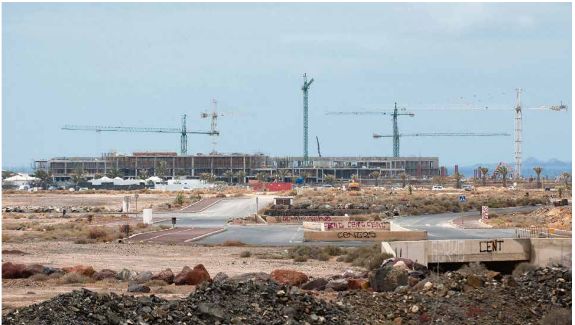
Hotel en construcción en Playa Blanca. Foto: Adriel Perdomo.
