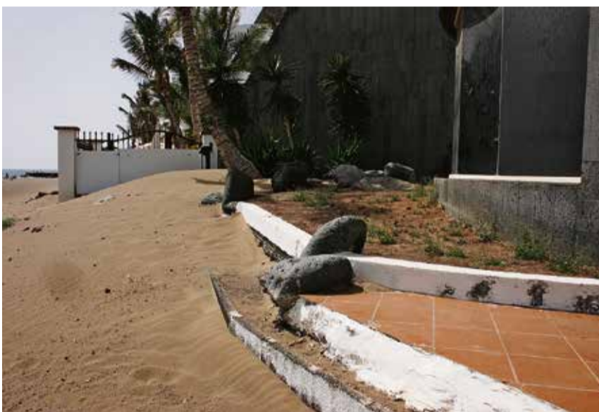
La construcción se adentra en la arena.
