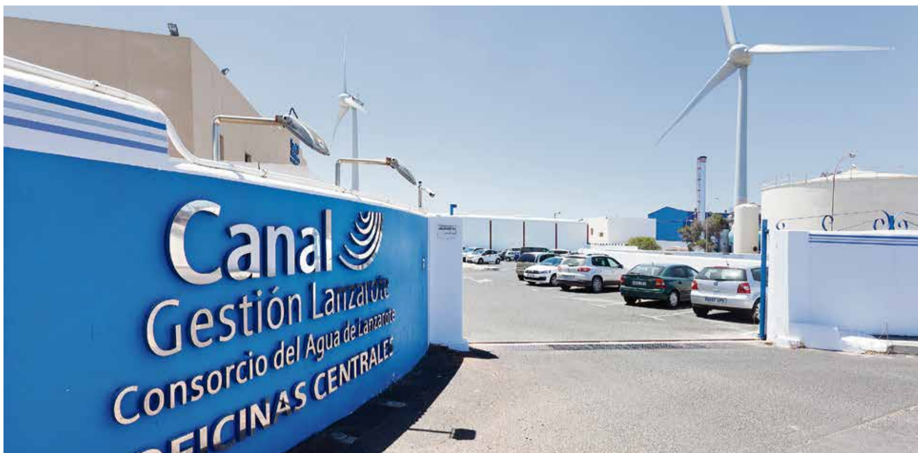
Entrada a la planta desaladora de Punta de los Vientos. Foto: Diario de Lanzarote.
