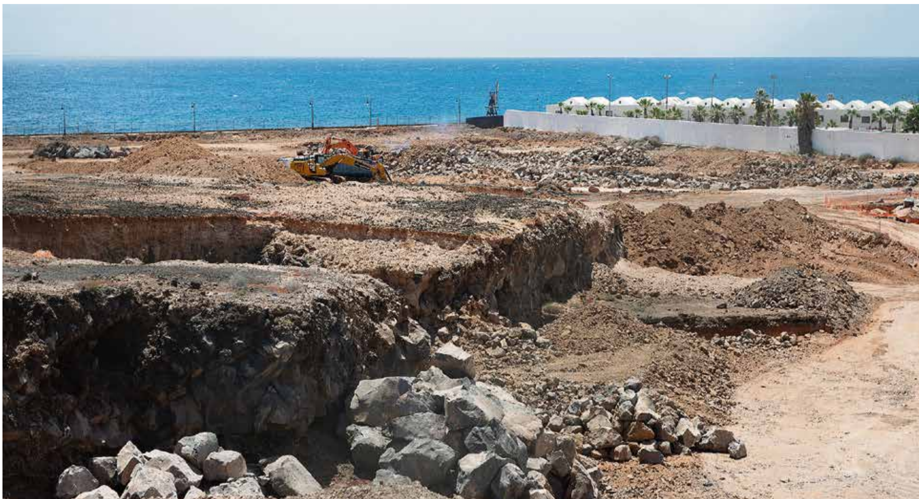
Obras de un nuevo hotel en Costa Teguise. Foto: Adriel Perdomo.
