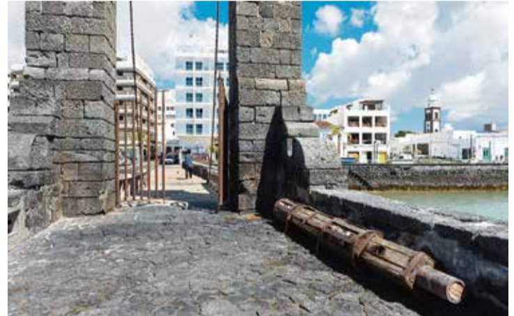
El ingenio que permitía el izado del puente levadizo, atomillado al suelo.
