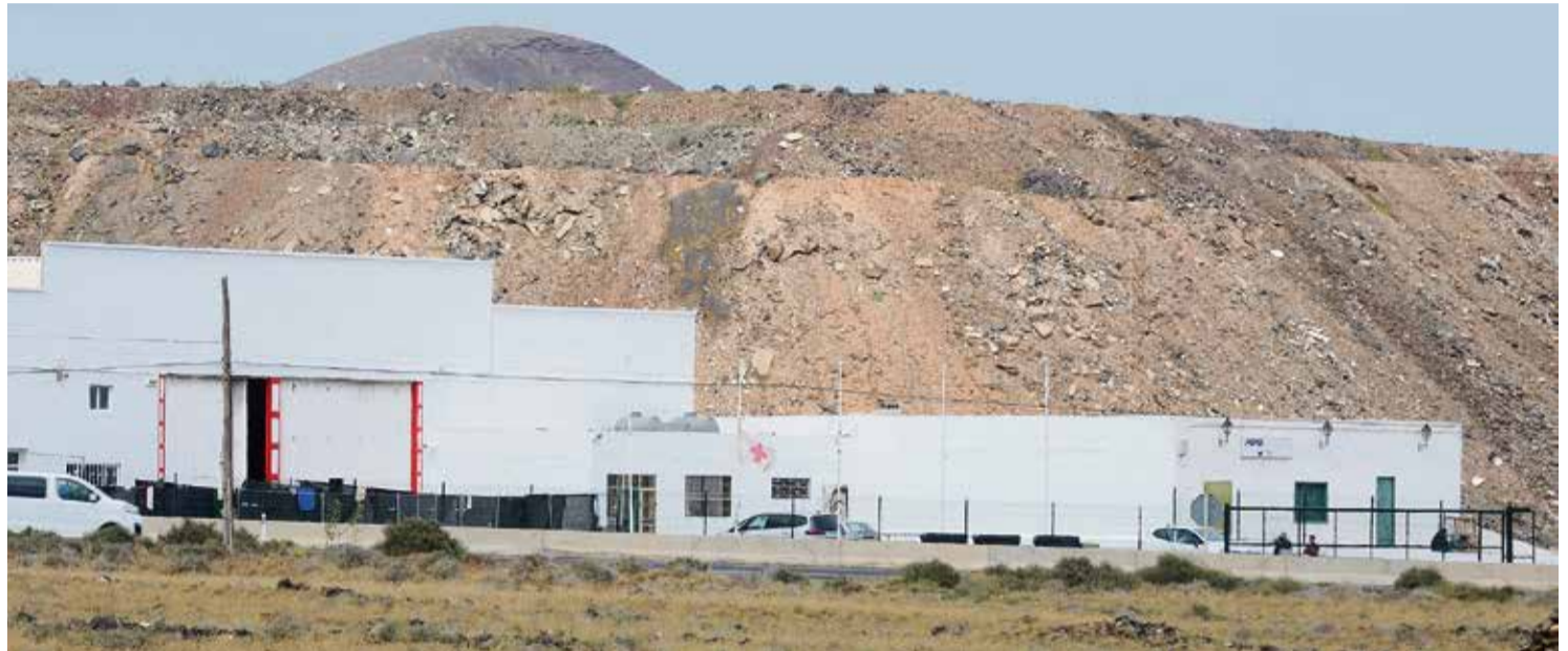
Instalaciones de acogida para migrantes en la carretera de Arrecife a San Bartolomé. Fotos: Adriel Perdomo.
