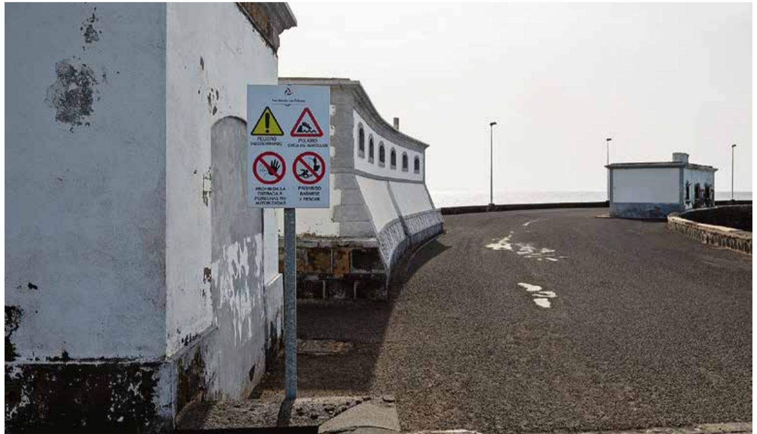
Instalaciones del antiguo muelle comercial de Arrecife. Foto: Adriel Perdomo.
