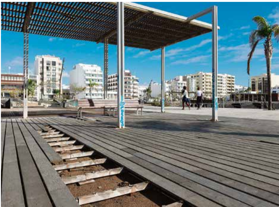
Los elementos arquitectónicos del parque están muy deteriorados por falta de mantenimiento.
