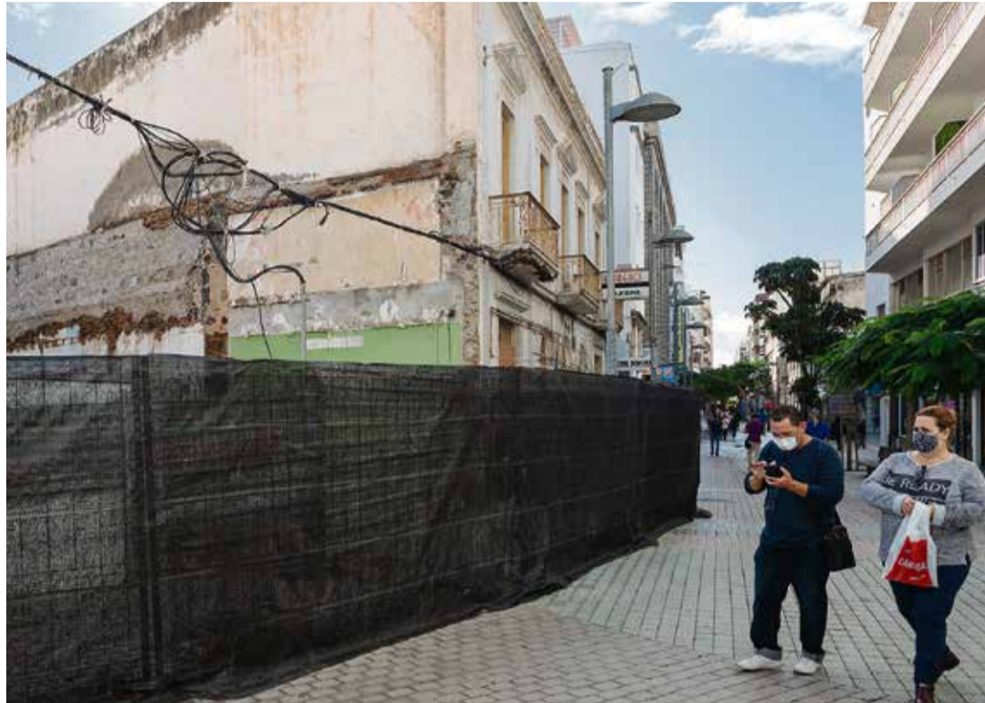
La antigua residencia Alespa y el hueco dejado por el derribo del comercio Alfa y del número 54 de la calle Real.
