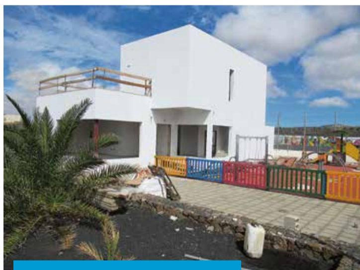
Aspecto del Centro Cívico de Las Caletas.
