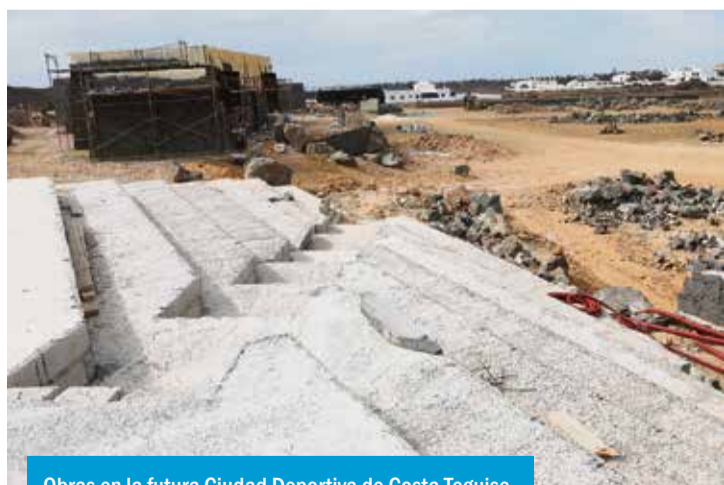
Obras en la futura Ciudad Deportiva de Costa Tegise.
